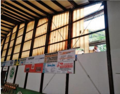
Abriss der alten Doppelstegwand, diese hat sich durch UV-Strahlung komplett verfärbt, ist brüchig und luftdurchlässig an gewissen Stellen geworden.
